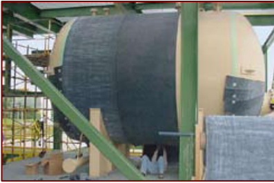
16' x 20' резервуар: Покрытия из Аэрогеля повышают производительность труда при работе с цистернами, резервуарами и на башнях.
