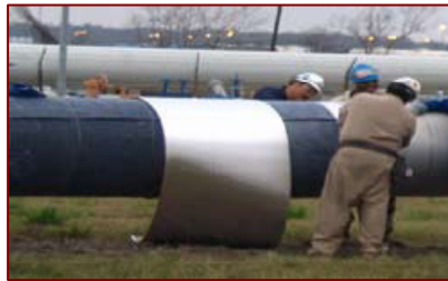
Модификации паропроводов: Простая, быстрая установка однослойного аэрогелевого защитного покрытия способна вытеснить влагу из старой, мокрой изоляции и восстановить эффективность системы.
