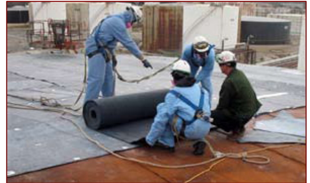
Крыши резервуаров: Аэрогель демонстрирует повышенный кпд крыш резервуаров.
