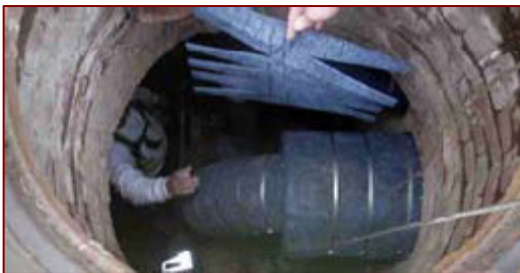
Труднодоступные участки: Гибкие покрытия из аэрогеля идеально подходят для применения в труднодоступных местах и могут выдерживать периодические затопления.
